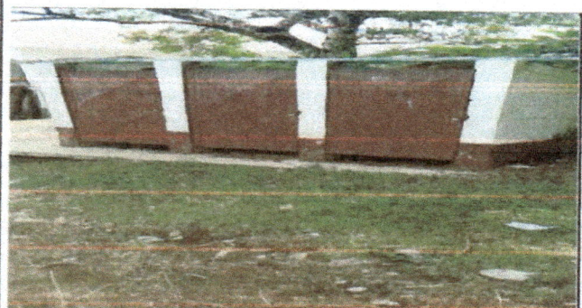
Foto 3: Mantenimiento de pared de baños y sustitucion de laminas en mal estado
